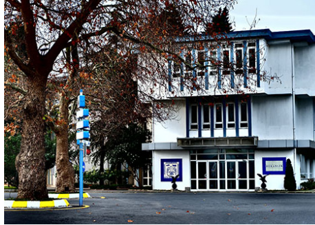
Harp Okulu Dekanlık Binası
